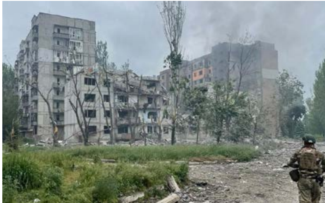
Gebäude in Advitka nach russischem Luftangriff – Foto: Donetsk Regional Military Civil Administration
